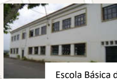
Escola Básica de Fijós Rua de Fijós 4440-334 Sobrado
